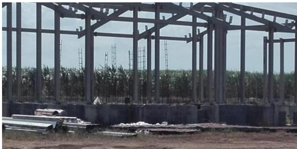
Figura N°6 Presidencia de la CSJ verifica avances de obras del Órgano Judicial Centro de Capacitación y Entrenamiento del Órgano Judicial, ubicado en el distrito de Santa María, provincia de Herrera
